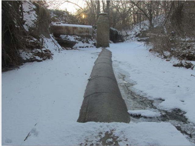
Site 29 - 4801 NE 34 th Terrace
